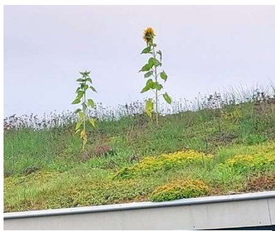
10 Zonnebloemen en sedum op het dak
